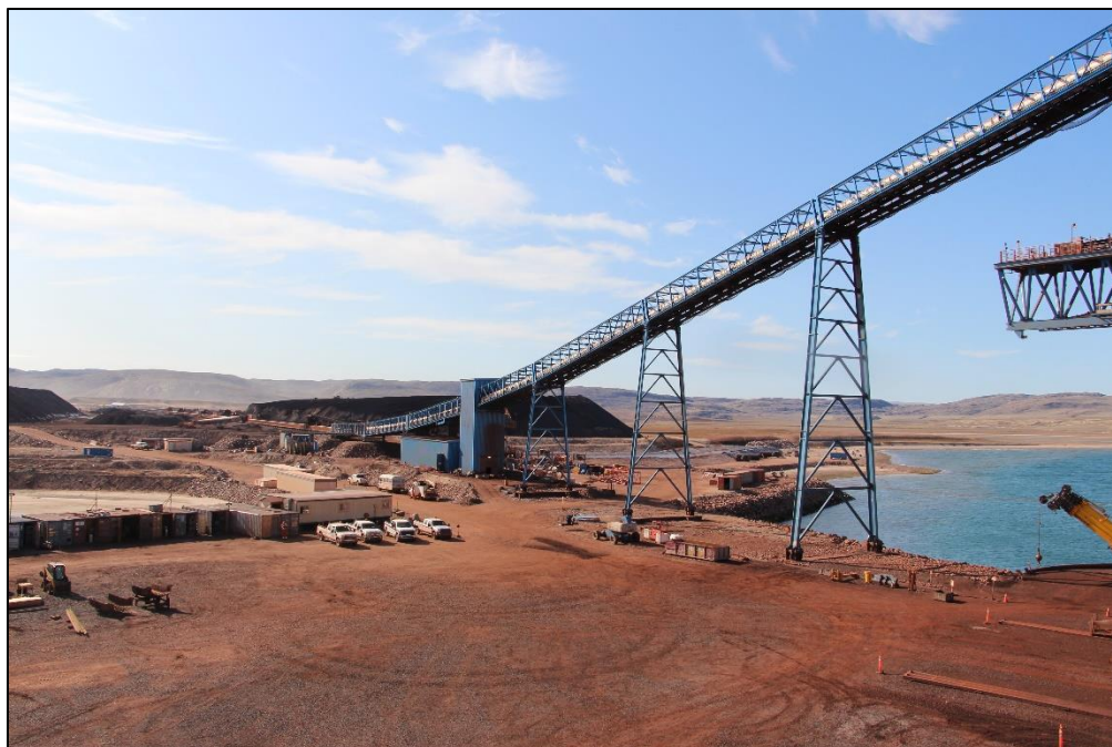
Photo 35: Quai minéralier et tapis transporteur pour le chargement des navires
