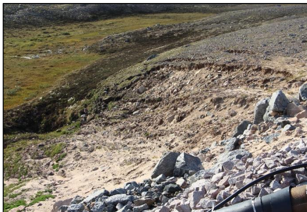
Photo 25: Terrain instable autour de la canalisation d'évacuation des eaux usées.
