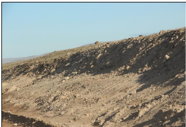
Photo 31: Érosion le long du chemin d'approvisionnement
