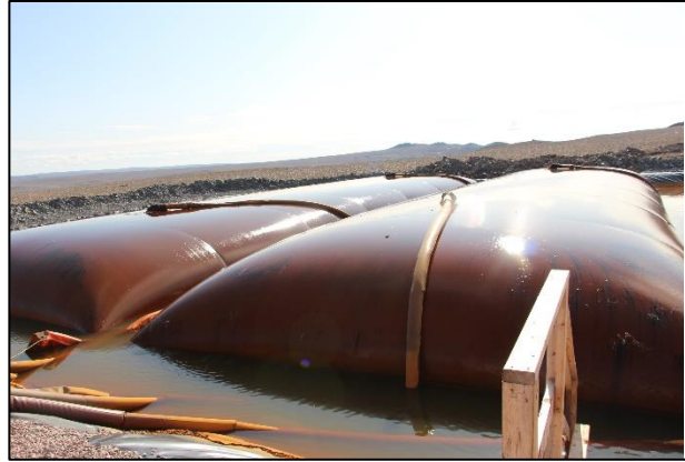
Photo 7: Vessies géotextiles utilisées pour séparer les particules des effluents de stériles.
