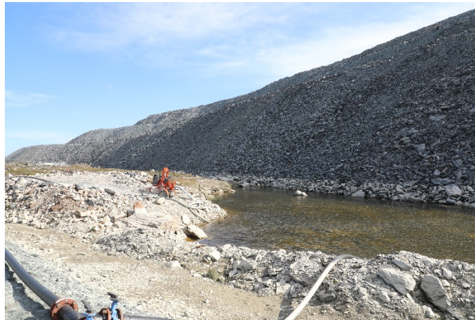
Photo 19: Ruissellement à l'installation d'entreposage des stériles de Portage
