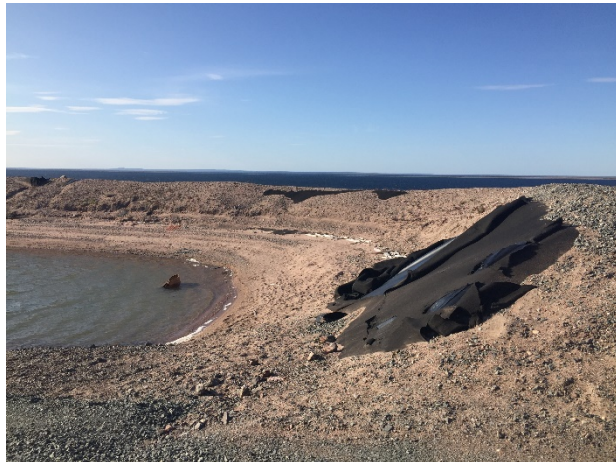
Photo 30: Revêtement exposé à l'air libre au parc de stockage des réservoirs de carburant de Baker Lake
