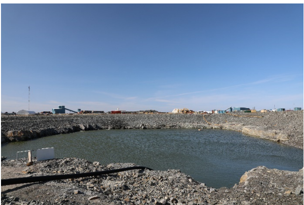
Photo 37 : Bassin d'eau saline qui stocke l'eau saline des activités souterraines au projet de mine d'or Meliadine
