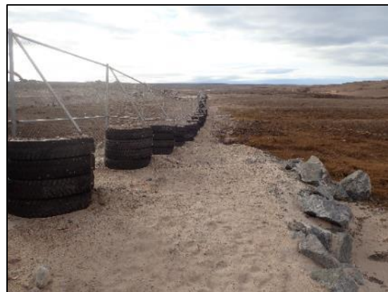
Photo 24: Clôture pare-détritus installée autour du site d'enfouissement
