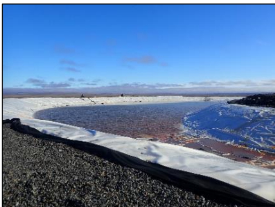
Photo 5: Bassin de décantation du dépôt de stockage des stériles
