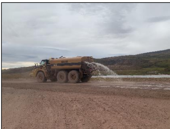
Photo 49: Camion d'eau appliquant l'abat-poussière au km 103
