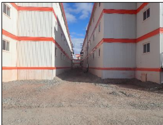
Photo 4: Plinthes en métal autour de la base du complexe d'hébergement Sailivik
