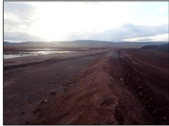
Photo 63: Berme nouvellement construite le long du périmètre sud de l'aire de stockage du minerai.
