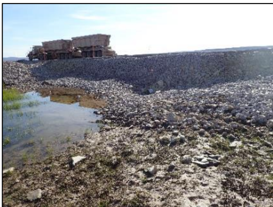
Photo 47: Réparations de l'endiguement au BG-33, km 77.
