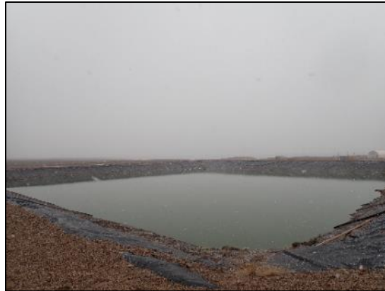
Photo 8: Bassin de polissage et de stabilisation des eaux usées, face à l'Est
