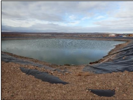
Photo 7: Bassin de polissage et de stabilisation des eaux usées, face à l'Ouest
