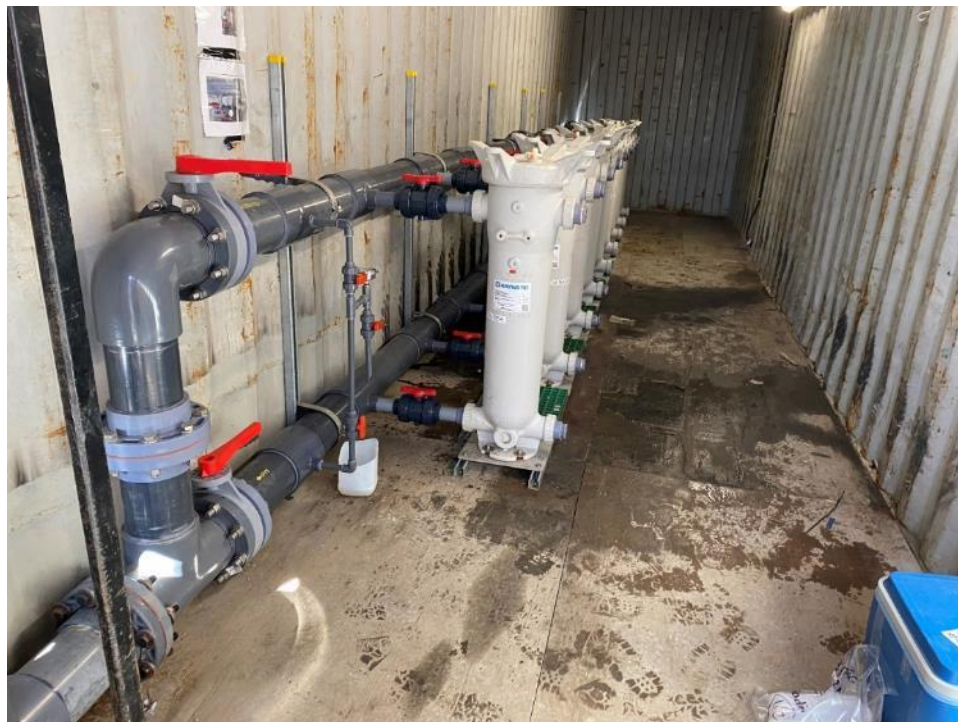
Photo 4: Station de filtrage des effluents salins installée en 2021
