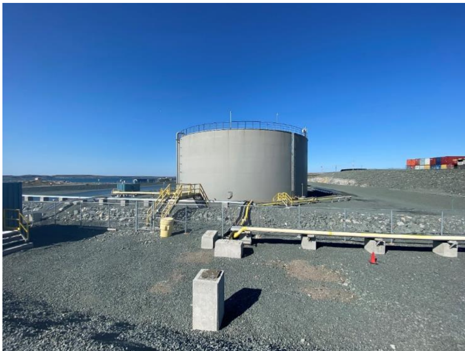
Photo 2: Parc 2 de stockage du carburant et confinement secondaire
