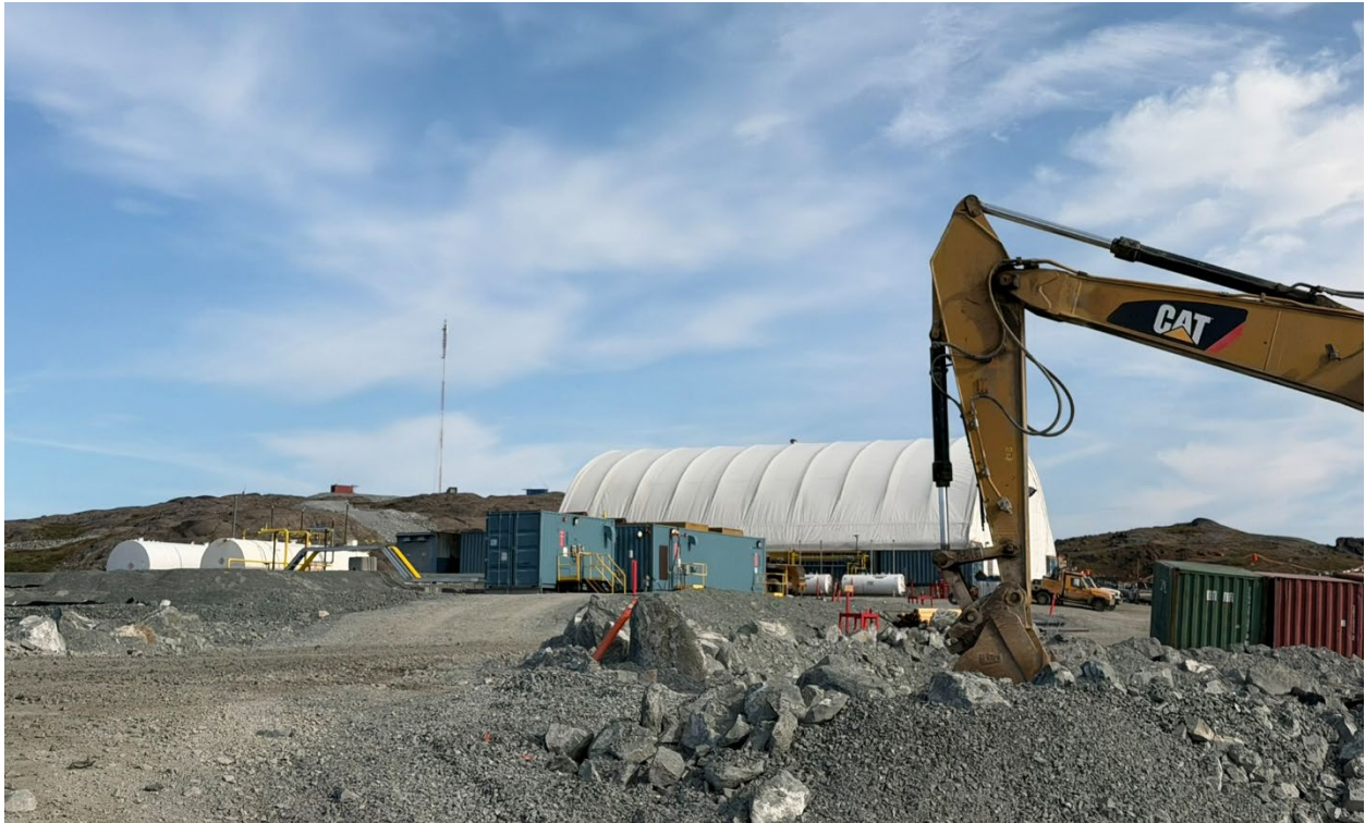
Photo 73: Naartok East CPR Laydown Pad
